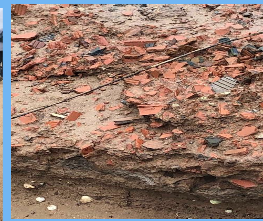
Entulho de obras de construção civil
