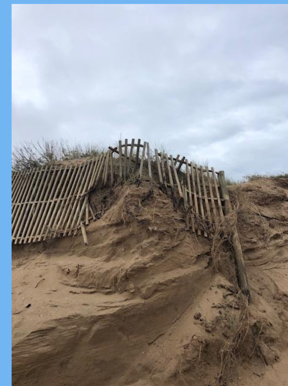
Controle da erosão - paliçadas de madeira
